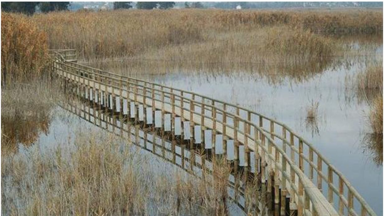
Hình 3.10. Cầu cạn gỗ tại Công viên Tự nhiên El Hondo
