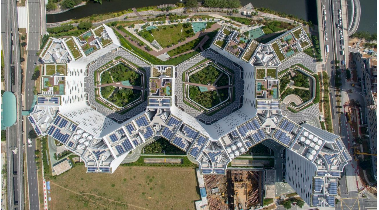
Hình 19: Mái của công trình sử dụng pin năng lượng mặt trời
